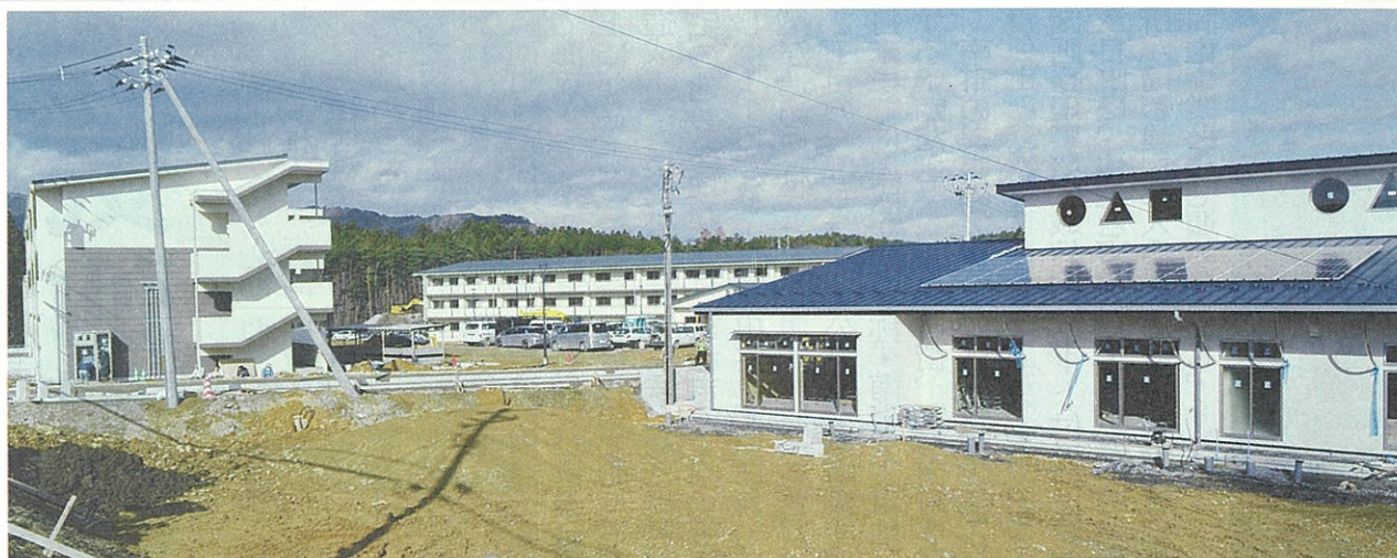
歌津地域で最大規模の歌津中学校上団地
